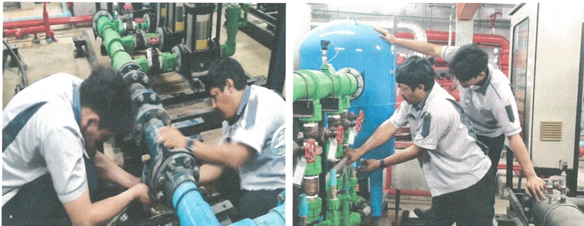
รูปภาพที่ 2.23 การตรวจสอบเส้นท่อประปา
