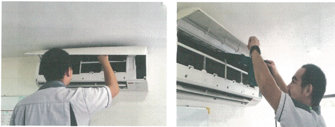
รูปภาพที่ 2.28 การล้างทำความสะอาดแอร์
