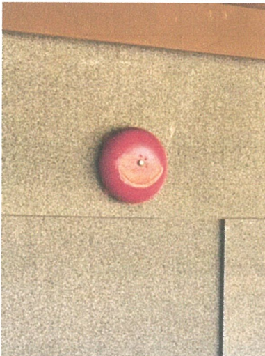
รูปภาพที่ 2.53 กริ่งสัญญาณเตือนภัย
