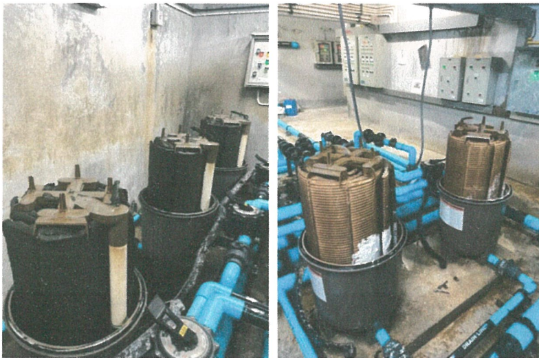
รูปภาพที่ 2.40 ตรวจสอบระบบกรองสระว่ายน้ำ
